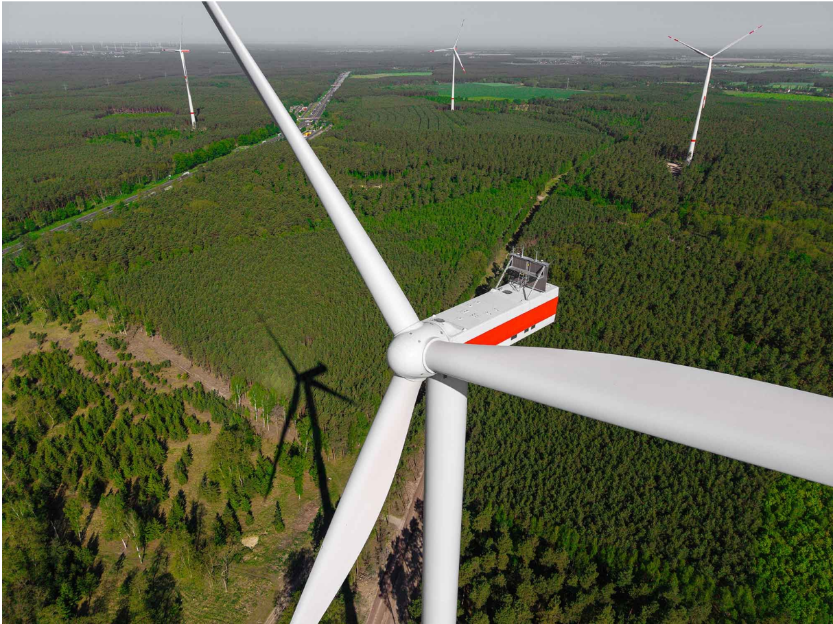
Bildtext: Windkraftanlagen des Projekts Dachsberg in Brandenburg. Quelle: NOTUS energy
